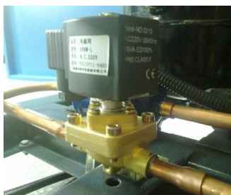
图 2-10: 液管电磁阀
