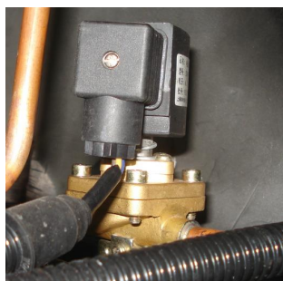
图 2-8: 热气旁通阀
