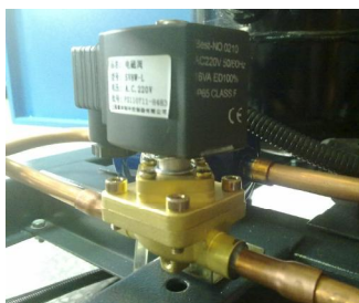
图 2-10: 液管电磁阀
