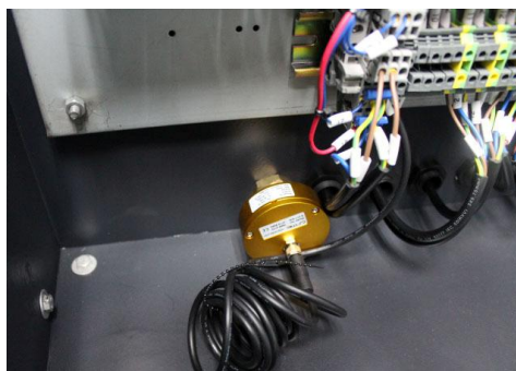
图 6-9: 安装露点计变送器
