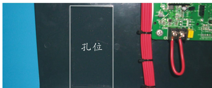
图 6-5: 露点计安装孔位
