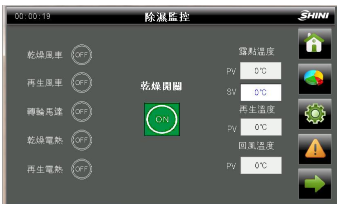
图 4-12: 除湿监控画面
