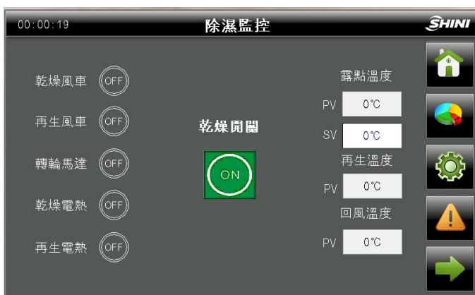
图 4-4：除湿监控画面
