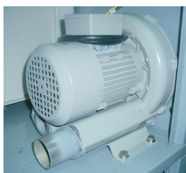
图 6-3: 干燥风机安装图
