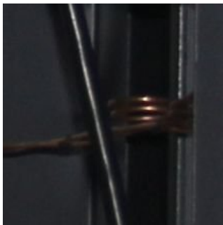
图 2-5: 毛细管或热力膨胀阀
